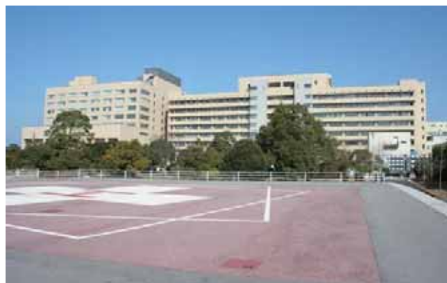
病院全景(南側)
