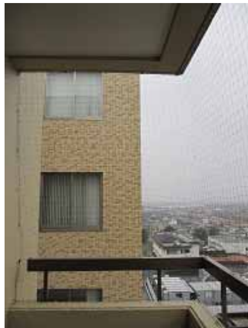
鳩よけネットの敷設状況
