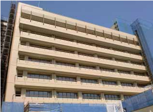
外壁塗装後のB病棟
