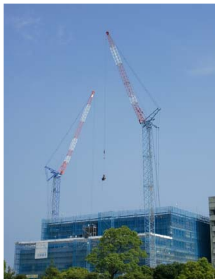
図1 新病等建設工事状況
