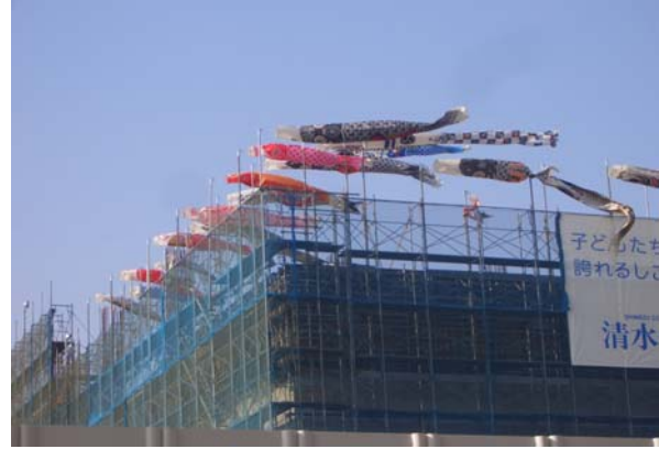
建設中の新病棟の上で泳ぐ55匹のこいのぼり
