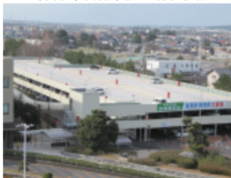
〈写真 2〉災害対応型立体駐車場
