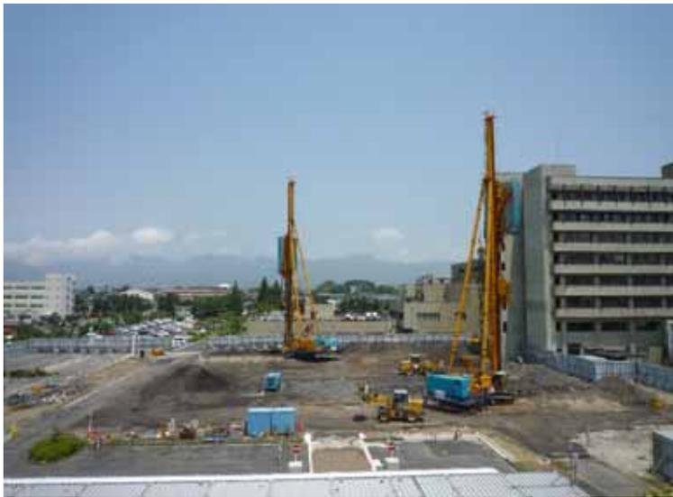
病棟新築現場状況(地盤改良用重機2台にて施工中) 南側より撮影
