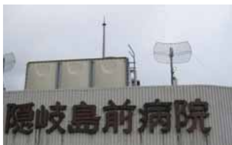
隠岐島前病院塔屋に設置した無線LANアンテナ
