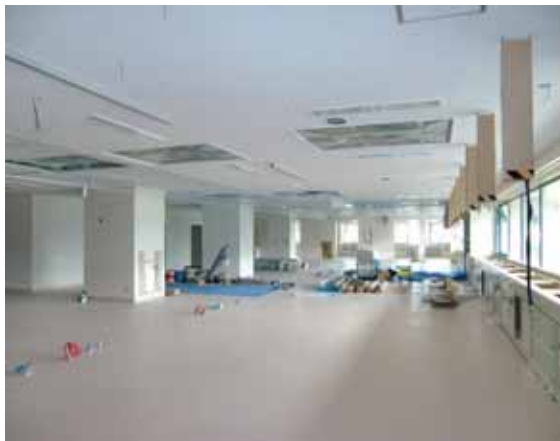
図3 工事中のICU(オープン病床スペース)
