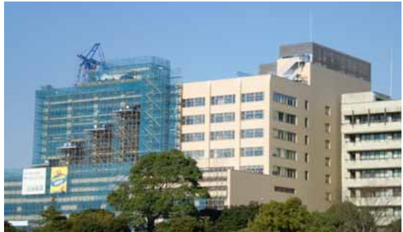
図1 足場が撤去されつつある新病棟
