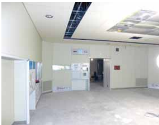
図4 工事中の手術室
