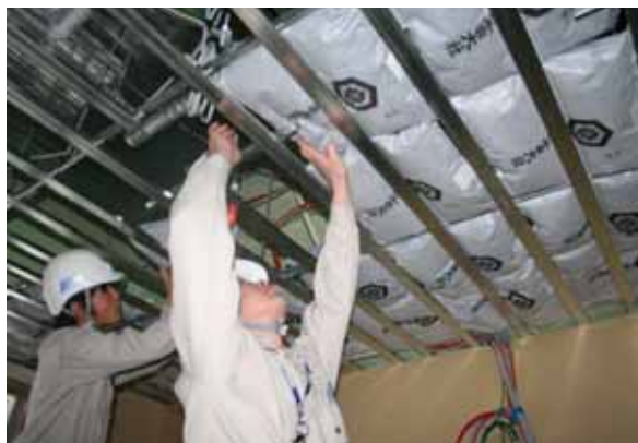
図5 病室天井裏へ敷設される檜皮炭
