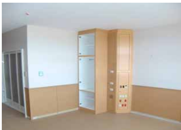
図6 内装工事中の個室病室
