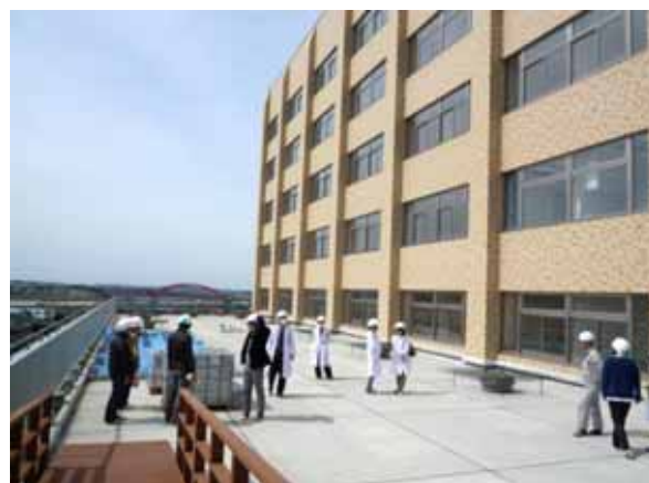
図4 5F緩和ケア病棟前の緑化屋上とウッドデッキ広場
