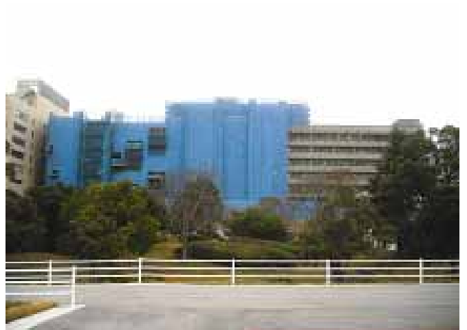
病棟南側外観
