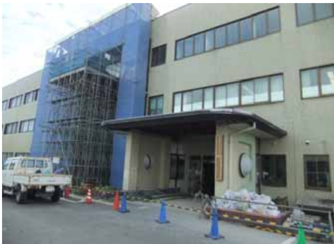
外部足場(外来・中央診療棟北側)
