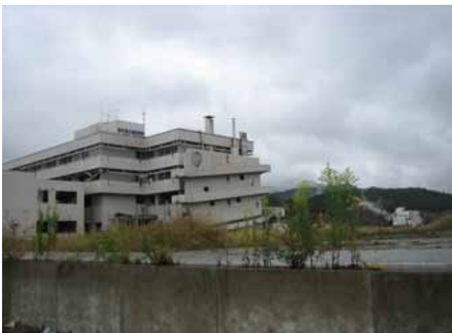
陸前高田市の県立高田病院 津波で4階まで被災し使用不能
