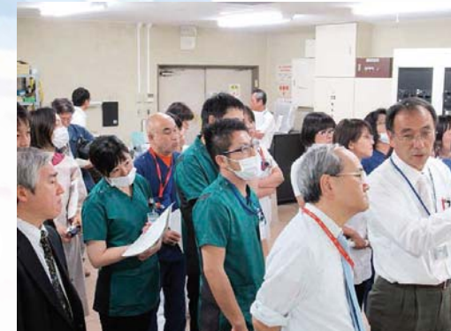
中央機械室集中管理盤前
