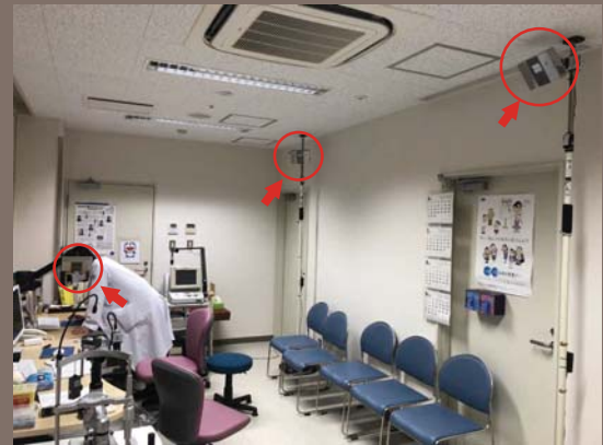
図1:眼科外来に設置された222nm紫外線照射装置(矢印)
