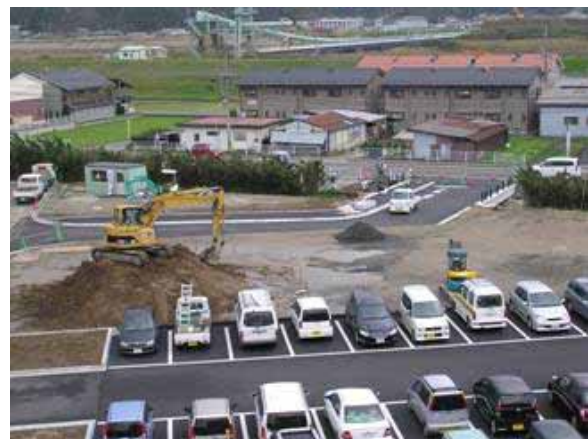
新設した南門と構内道路状況
