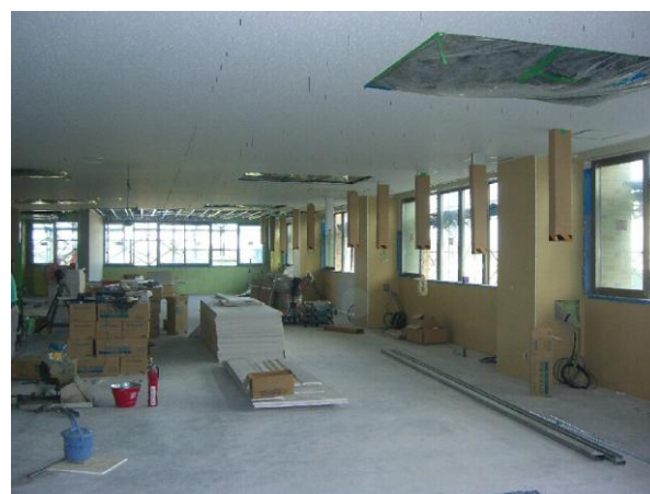
新病棟建物内現場状況 (2階 ICU 病室)
