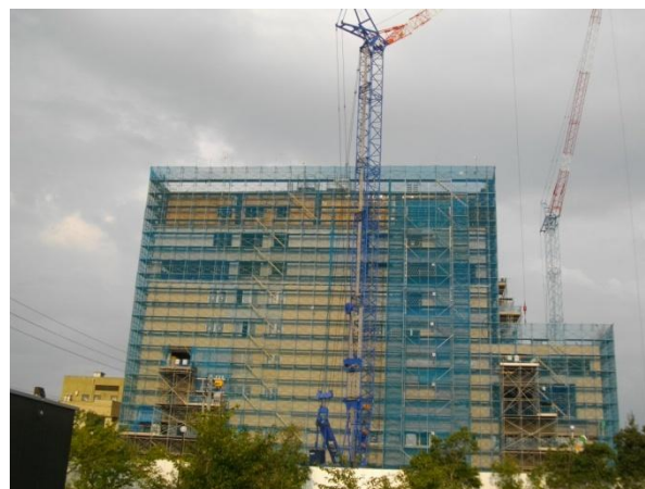
病棟新築現場状況 (西側より撮影)
