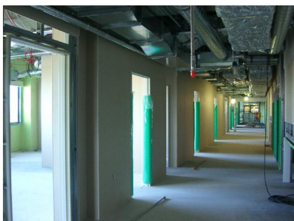
新病棟建物内現場状況 (3階北側居室)
