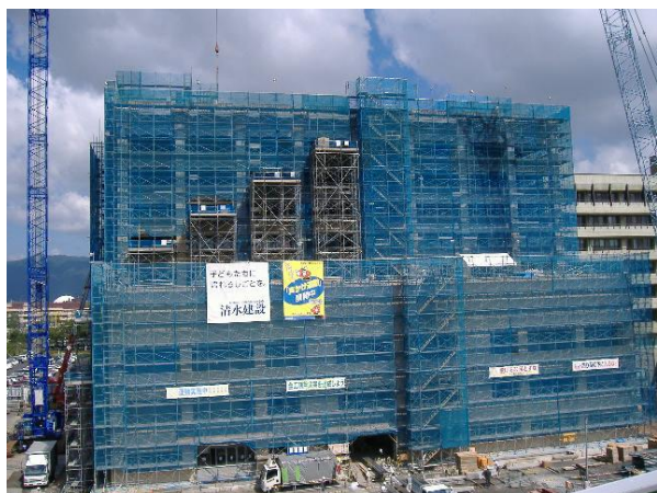
病棟新築現場状況 (南側より撮影)
